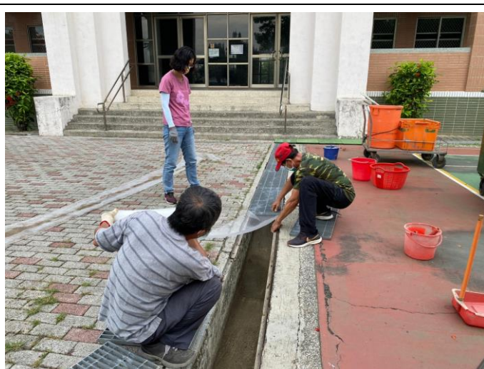
志工與教師協助鋪設鐵網與清理水溝
