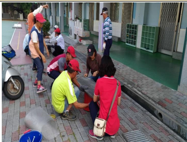
高齡志工協助鋪設水溝鐵網
